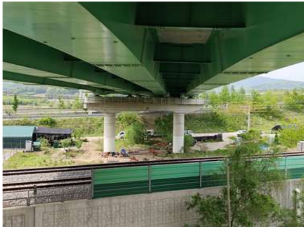
교각 P5 기초 전경
