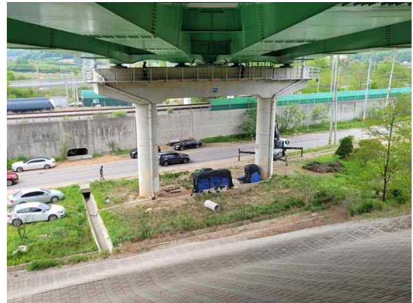
교각 P6 기초 전경
