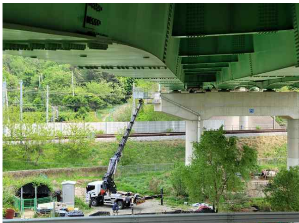
고소작업차를 이용한 근접조사
