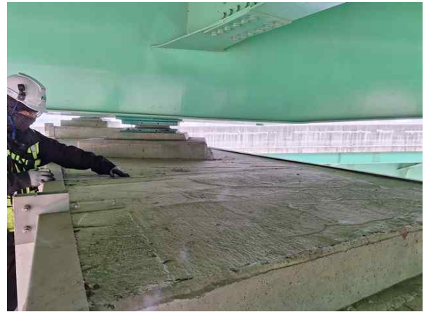
도보점검을 이용한 부재치수 현장측정
