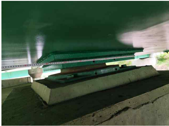
도보점검을 이용한 부재치수 현장측정
